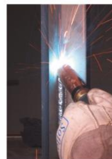
Вертикальный шов снизу вверх
